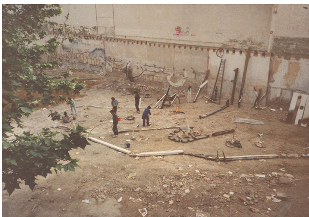
Muntatge d'una instal·lació a la Casa de la Caritat (curs 1988-1989). David Izquierdo.
